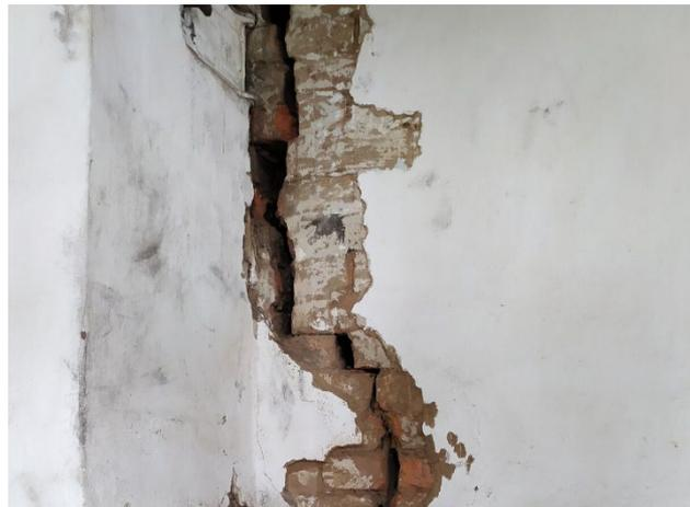
имеется сквозная трещина в печи
