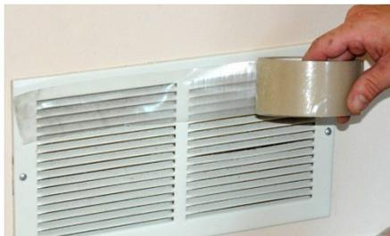
вентиляционная решетка, расположенная в видимой части помещения, закрыта (заклеена) посторонними предметами
