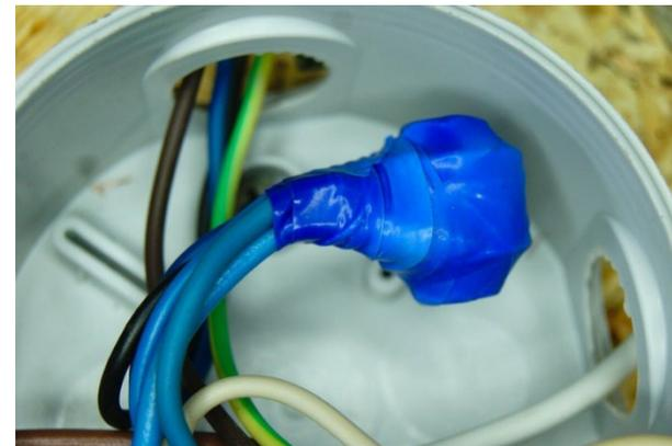
соединение проводов, кабелей, расположенных в видимой части помещения, выполнено методом скрутки
