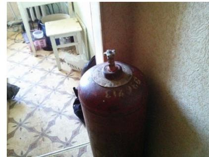
допускается хранение газовых баллонов в неподключенном состоянии
